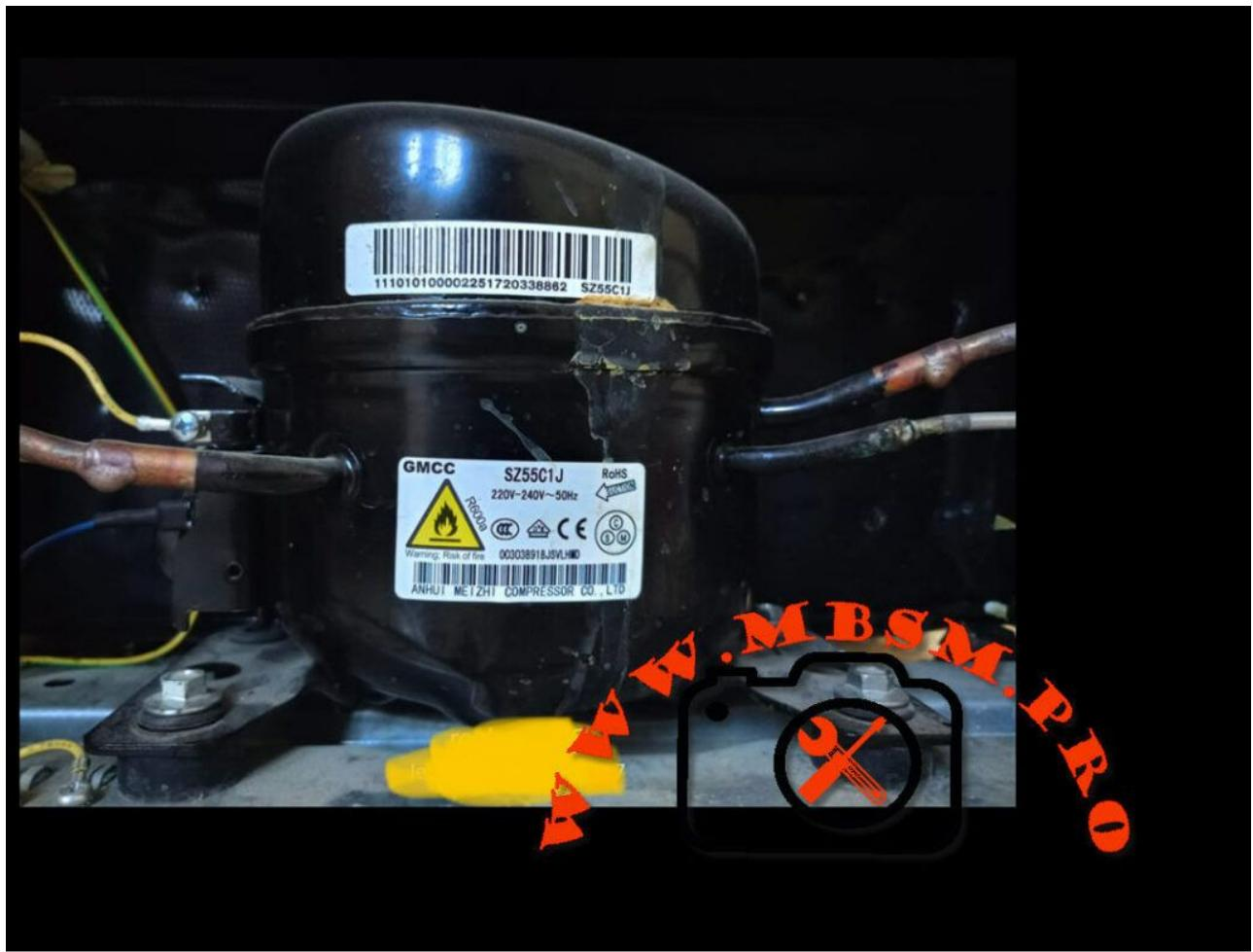
Réfrigérateur, BTOP107SL, Mini compresseur, GMCC, Série C, TOSHIBA, SZ55C1J, 75 w, 1/10 hp, LBP, r600a, Réfrigérateur-Congélateur, HRD-071S, 64 L
